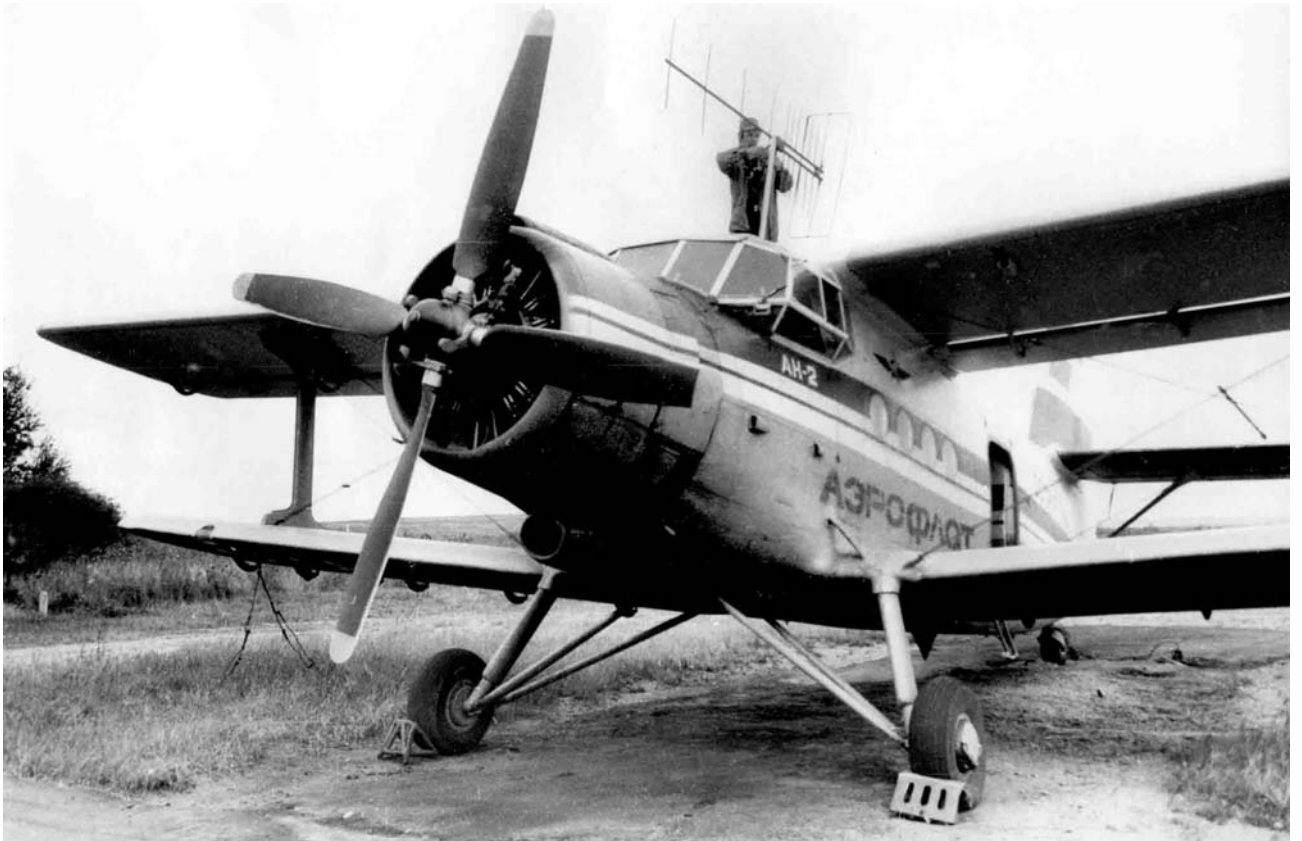
Рис. 13. Самолет АН-2, оборудованный пеленгационной системой
