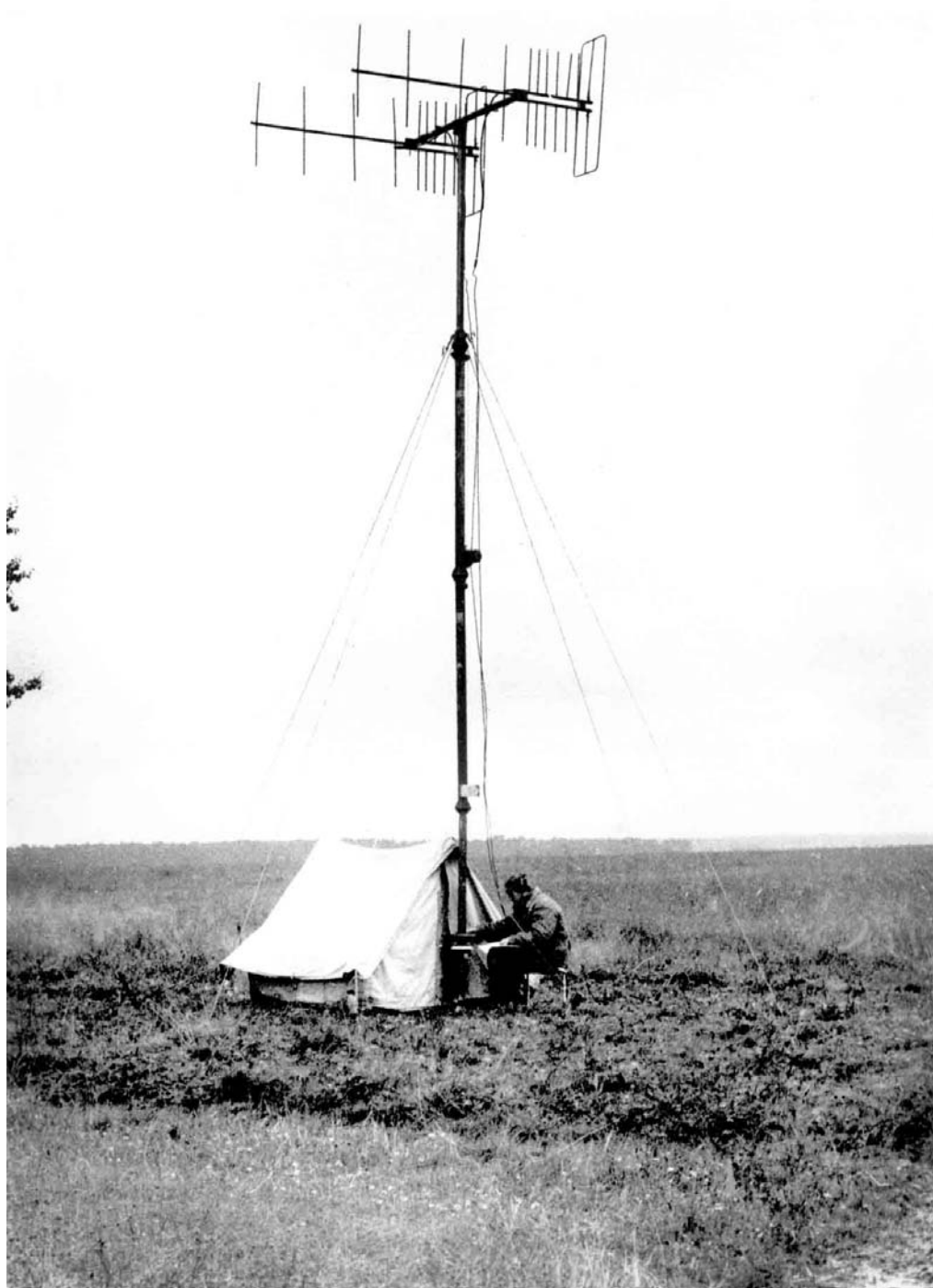
Рис. 10. Перевозимая 7,5-метровая мачта с пеленгационной антенной. Время разворачивания 15-20 минут
